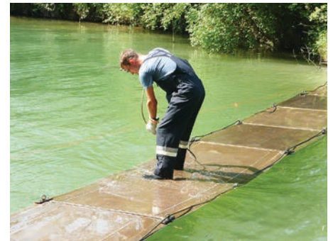
Pontonbrücke des THW.
